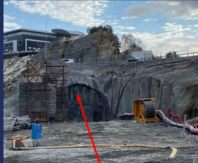
Bilde: Sprengningsmatte av bildekk og kabler.
